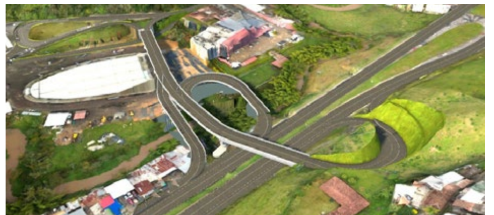
El proyecto vial incluye nuevos carriles y un puente peatonal en el sector El Cordobés para mejorar la movilidad y la seguridad
